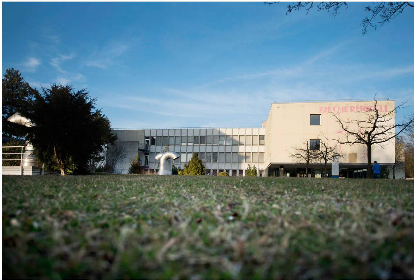
Hier soll dereinst die Technische Fachschule zu Hause sein: Heutiger Fachhochschul-Standort Gsteig in Burgdorf. Foto: Valérie Chételat
